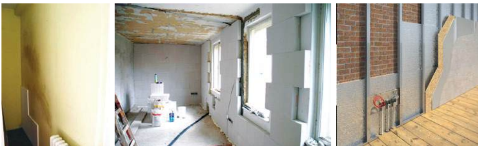
Slika 73 Primjeri izolacije s unutarnje strane
