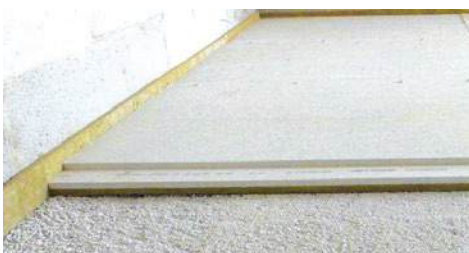
Slika 115 Primjer suhog estriha na nasipu od perlita
