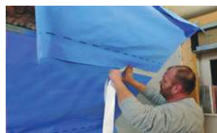
6) brtvljenje spojeva aktivne parne brane specijalnom ljepljivom trakom u potpunosti
