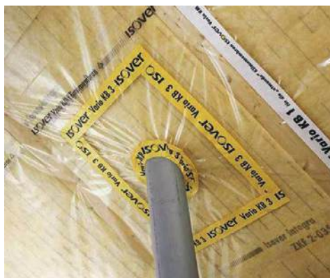
Slika 104 Lijepljenje parne brane i brtvljenje prodora
