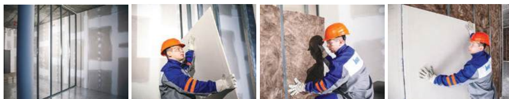
Slika 91 Postupnost formiranja pregradnog suhomontažnog zida
