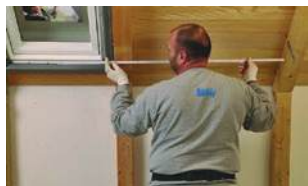
1) upuštanje sidrenih ovjesa na rogove za postavljanje CD profila
