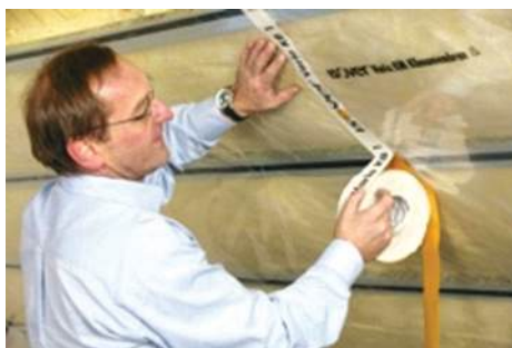
Slika 72 Lijepljenje parne brane s pristupom iznutra
