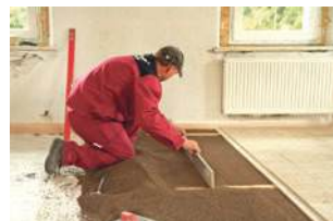
Primjer izvedbe estriha sa suhim nasipom
