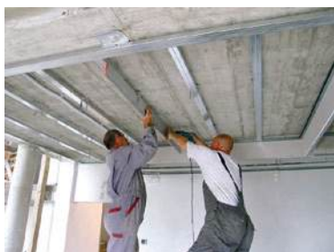
Slika 94 Spušteni strop s direktnim pričvršćenjem potkonstrukcije
