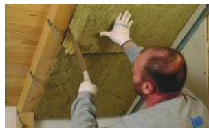
3) ugradnja ploča mineralne vune između rogova tijesno, jednu do druge
