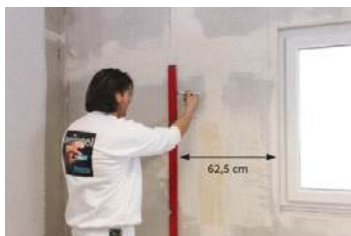
Postavljanje potkonstrukcije, drvene ili metalne
