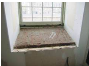
Slika 82 Izvedena unutarnja izolacija stana bez izolacije prozorske klupčice nije preporučljiva
