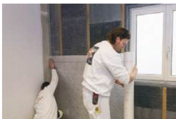
Ugradnja parne brane
