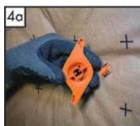
Pričvršćenje toplinske izolacije pomoću odgovarajuće spojnice (kapice)
