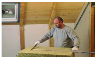
2) izrezivanje ploča mineralne vune za 0,5-1 cm šire od razmaka rogova
