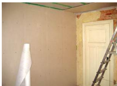
Postavljanje gipskartonskih ploča s fiksiranjem na mjestima drvenih nosača
