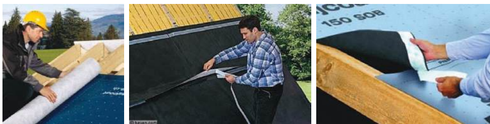
Slika 65 Postavljanje paropropusno-vodonepropusne folije (kišne brane)
