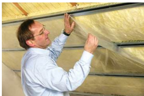
Slika 71 Postavljanje parne brane s pristupom iznutra
