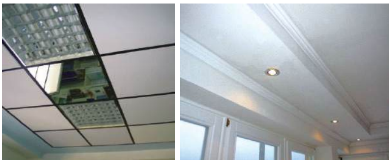
Slika 93 Spušteni stropovi prema vidljivosti potkonstrukcije
