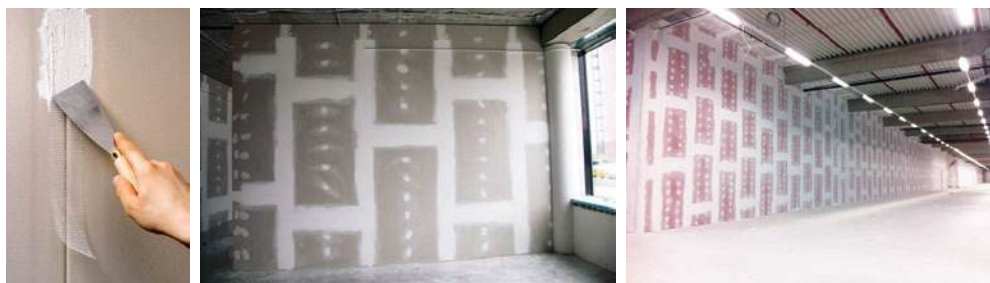
Slika 124 Primjena bandažne trake i ispunjivača spojeva
