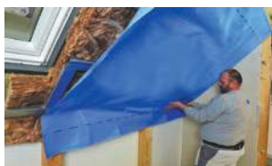
5) postava pametne parne brane preko CD profila s preklapom od 10 do 15 cm
