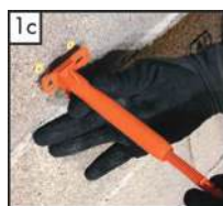
Ugradnja pričvrsnice direktno u zid
