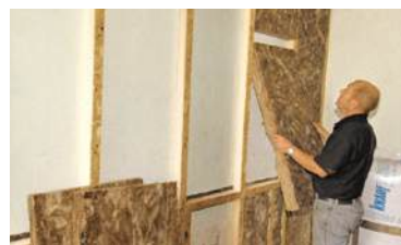
Prikaz postavljanja toplinske izolacije od mineralne vune te postavljanje parne brane na drvenu potkonstrukciju
