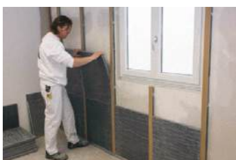
Ugradnja toplinske izolacije
