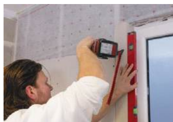
Ugradnja gipskartonskih ploča
