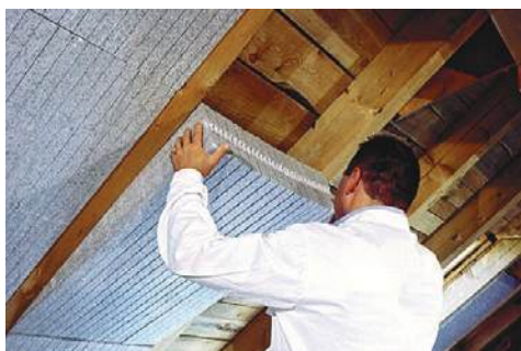
Slika 105 Specijalni proizvodi od EPS-a za izolaciju između rogova
