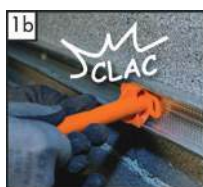
Ugradnja pričvrsnice u metalnu vodilicu
