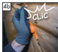
Pričvršćenje toplinske izolacije pomoću odgovarajuće spojnice (kapice)
