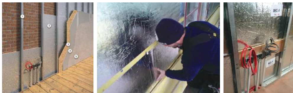
Slika 78 Prikaz unutarnje izolacije korištenjem vakuum izolacijskih ploča
