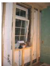
Drvena potkonstrukcija za unutarnju izolaciju
