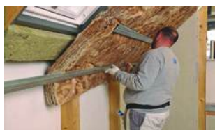
4) ugradnja drugog sloja mineralne vune preko prvog sloja i rogova, te fiksiranje CD profila
