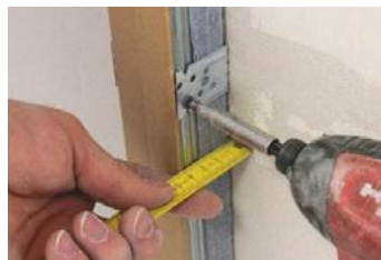
Ugradnja gipskartonskih ploča
