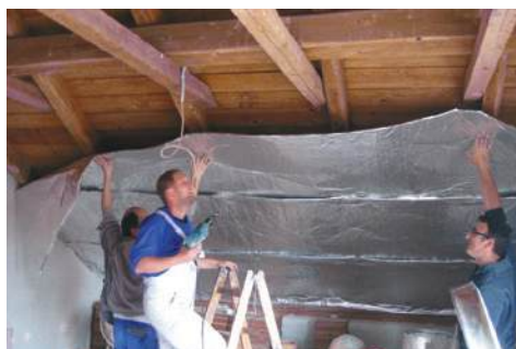
Slika 106 Primjer krovišta obloženog reflektirajućom folijom
