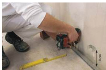
Ugradnja toplinske izolacije
