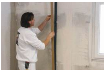
Ugradnja parne brane
