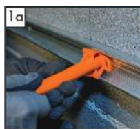
Ugradnja pričvrsnice u metalnu vodilicu
