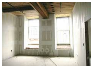
Slika 82 Izvedena unutarnja izolacija stana bez izolacije prozorske klupčice nije preporučljiva
