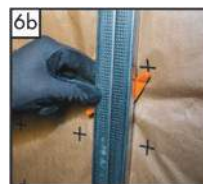
Izvlačenje teleskopske pričvrsnice do potrebne debljine toplinske izolacije i ugradnja i pričvršćenje metalne potkonstrukcije za izvođenje obloge od gipskartonskih ploča vrsnice do potrebne debljine toplinske izolacije
