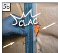
Izvlačenje teleskopske pričvrsnice do potrebne debljine toplinske izolacije i ugradnja i pričvršćenje metalne potkonstrukcije za izvođenje obloge od gipskartonskih ploča vrsnice do potrebne debljine toplinske izolacije
