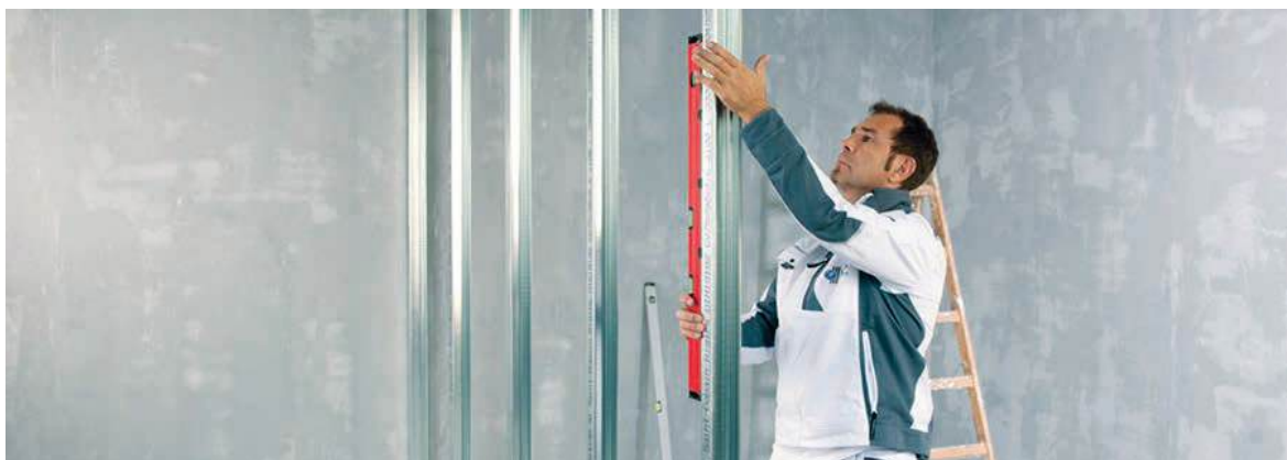
Slika 2-44 Čelična potkonstrukcija pregradnog zida [99]
