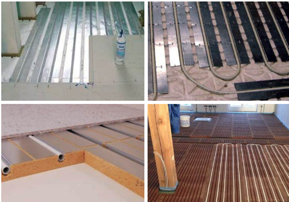
Slika 2-136 Primjeri postavljanja elemenata za podno grijanje [91], [181], [182], [38]
