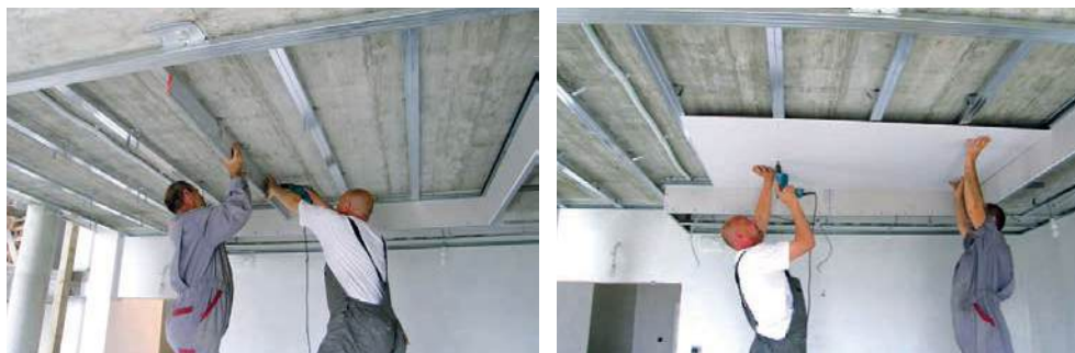
Slika 2-68 Izvedba spuštenog stropa s direktnim pričvršćenjem potkonstrukcije [91]
