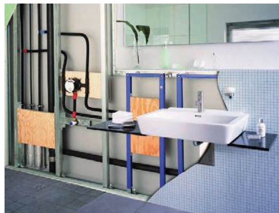
Slika 2-62 Instalacijski vodovi na površini zida izvedeni suhom gradnjom [120]
