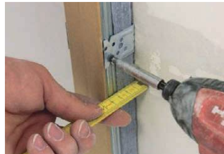
Ugradnja gipskartonskih ploča
