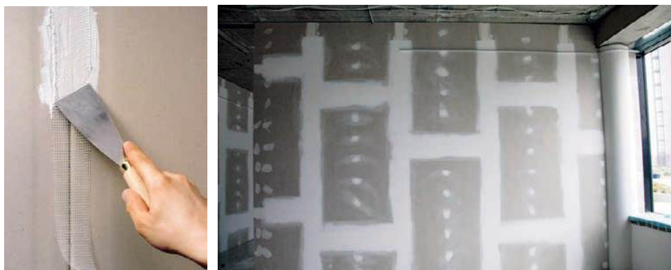
Slika 2-148 Primjena bandažne trake i ispunjivača spojeva [208], [1]
