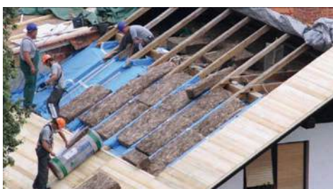
5) Postavljanje mekane mineralne vune između rogova
