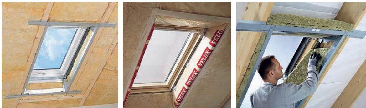
Slika 2-106 Postavljanje potkonstrukcije, toplinske izolacije i parne brane oko krovnog prozora [142]
