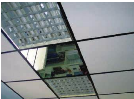
Slika 2-63 Spušteni strop s vidljivom potkonstrukcijom [121]
