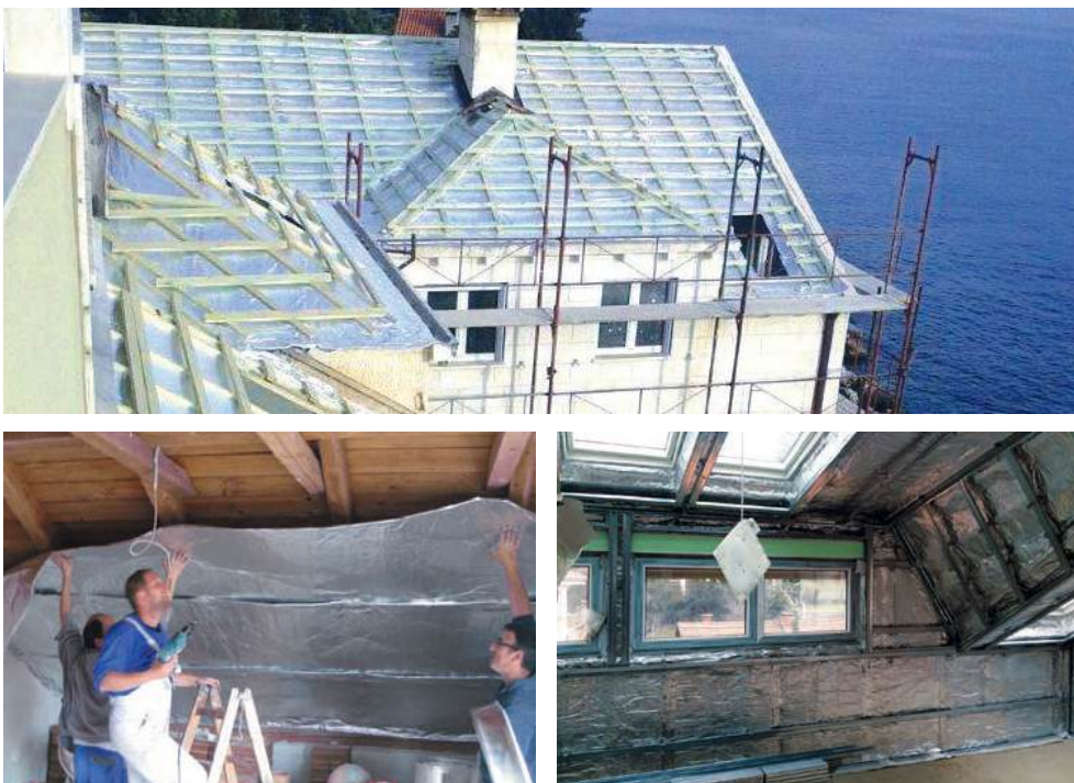
Slika 2-103 Primjer krovišta obloženog reflektirajućom folijom [140]
