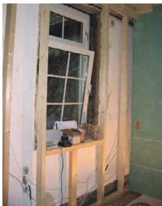
Slika 2-10 Drvena potkonstrukcija za unutarnju izolaciju [92]
