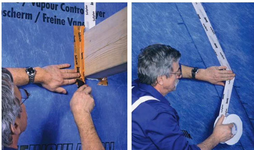
Slika 2-29 Lijepljenje parne brane [1]
