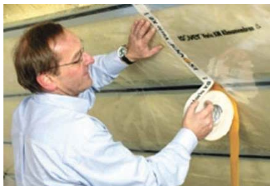
Slika 1-83 Lijepljenje parne brane s pristupom iznutra [81]
