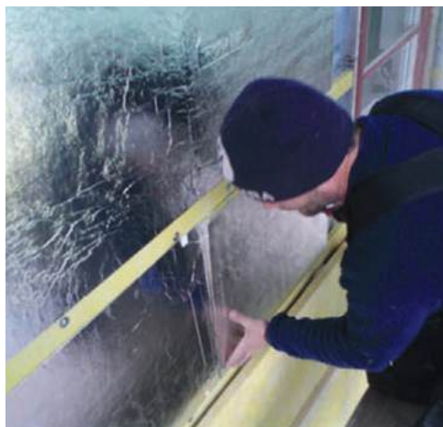
Slika 2-16 Prikaz unutarnje izolacije korištenjem vakumizolacijskih ploča [96]
