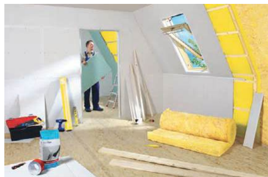
Slika 2-87 Oblaganje potkrovlja suhom gradnjom [130]
