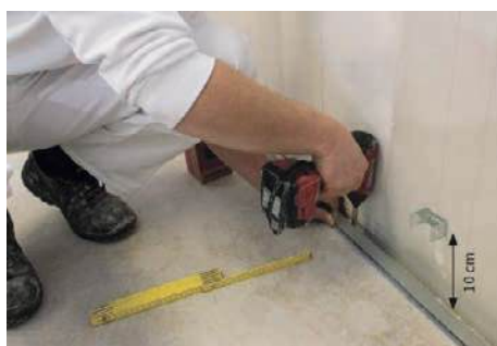
Ugradnja toplinske izolacije
