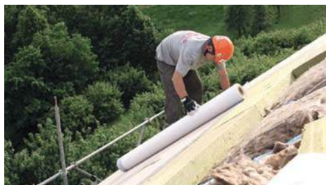
7) Izvedba paropropusne-vodonepropusne barijere
