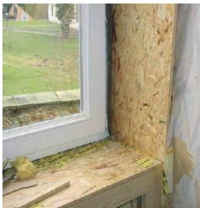
Slika 2-11 Unutarnja obloga izvedena korištenjem OSB ploča ili gipskartonskih ploča na sloj toplinske izolacije i parne brane [92]
