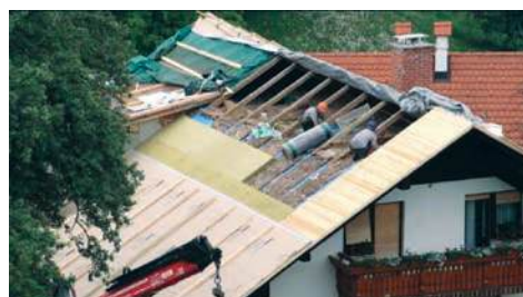
10) Toplinska izolacija postojećeg krova
