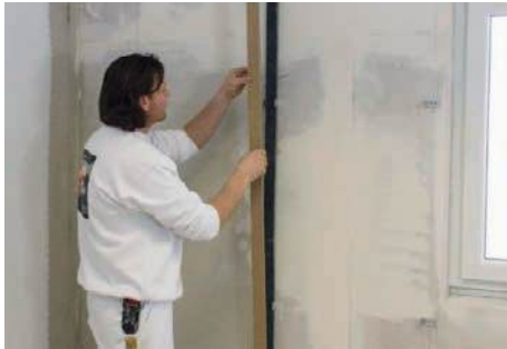
Ugradnja parne brane
