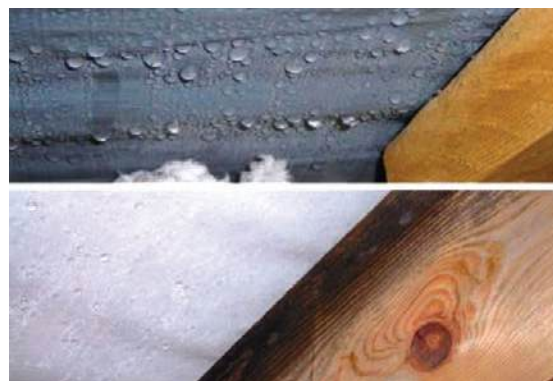
Slika 1-74 Primjer kondenzacije vodene pare na neprikladnoj krovnoj foliji drvenog krovšta [73]
