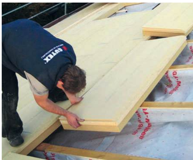
Slika 2-115 Primjer loše izvedbe izolacije jer je međuprostor između rogova ostao neizoliran; pojava strujanja u međuprostoru može povećati gubitke topline [151]
