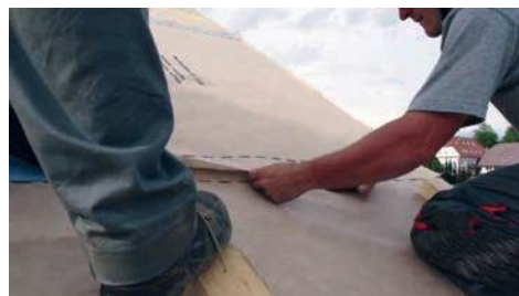
8) Postavljanje paropropusne-vodonepropusne folije s preklpom
