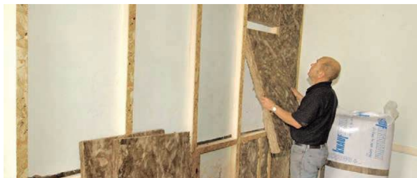
Slika 2-13 Prikaz postavljanja toplinske izolacije od mineralne vune te postavljanje parne brane na drvenu potkonstrukciju [93], [94]
