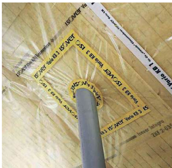
Slika 2-101 Lijepljenje parne brane i brtvljenje prodora [81]
