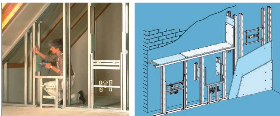
Slika 2-60 Nosači od pocinčanog čelika kod pregradnog instalacijskog zida [117], [91]
