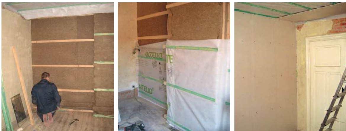
a) Postavljanje izolacije od industrijske konoplje između nosača potkonstrukcije
