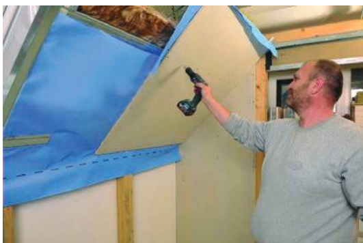
Slika 2-100 Postupak postavljanja toplinske između i ispod rogova [139]
