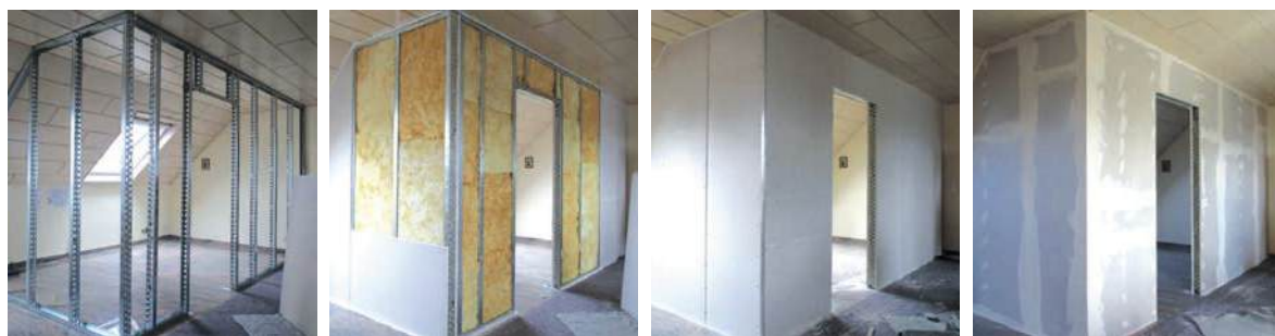
Slika 2-48 Postupnost formiranja pregradnog suhomontažnog zida [113]
