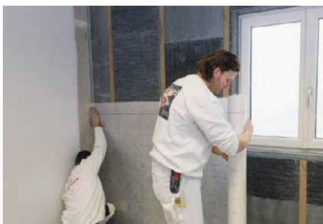
Ugradnja parne brane
