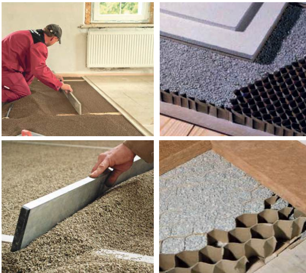
Slika 2-127 Primjeri moguće izvedbe estriha sa suhim nasipom [165], [100], [166], [167]
