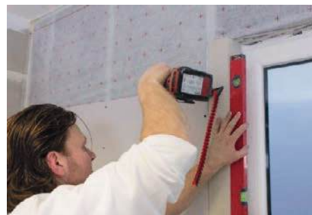
Ugradnja gipskartonskih ploča
