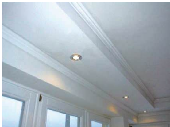
Slika 2-64 Spušteni strop s nevidljivom potkonstrukcijom [122]
