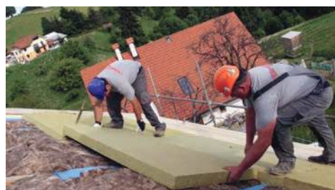
6) Prekrivanje rogova s gornje strane pločama mineralne vune velike čvrstoće
