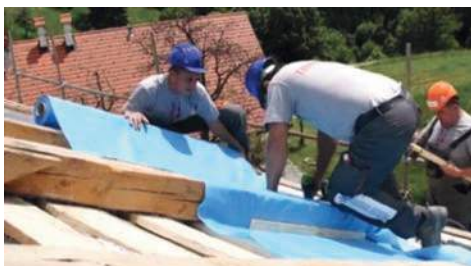
1) Postavljanje parne brane s gornje strane rogova
