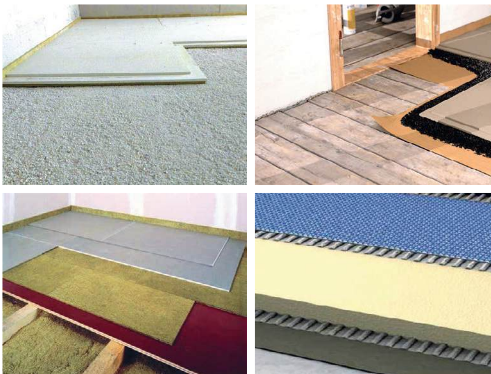
Slika 2-123 Primjeri različitih podloga na koje se može postaviti suhi estrih [161], [162], [1], [163]
