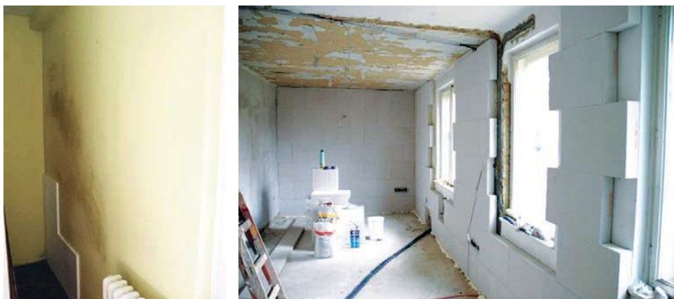
Slika 2-3 Primjeri izolacije s unutarnje strane [85], [86]
