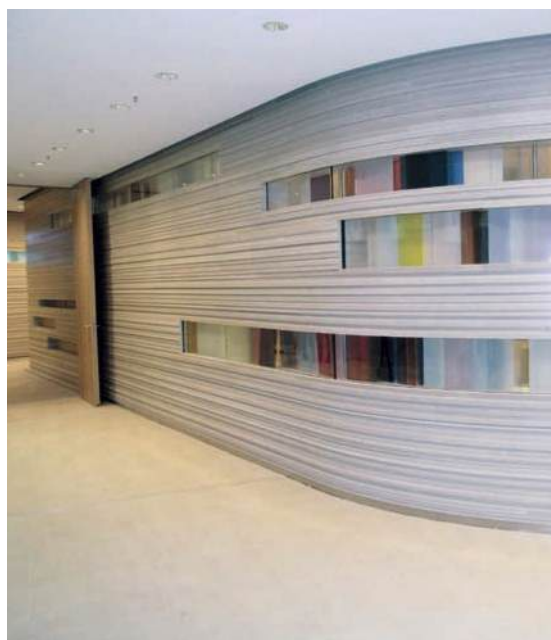
Slika 1-2 Zakrivljeni zid izveden suhom gradnjom [2]
