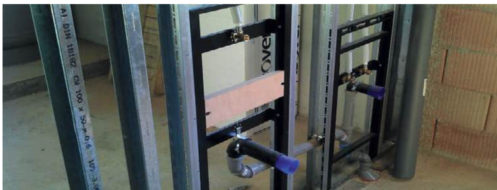
Slika 2-61 Potkonstrukcija za instalacijski zid s nosačima [119]
