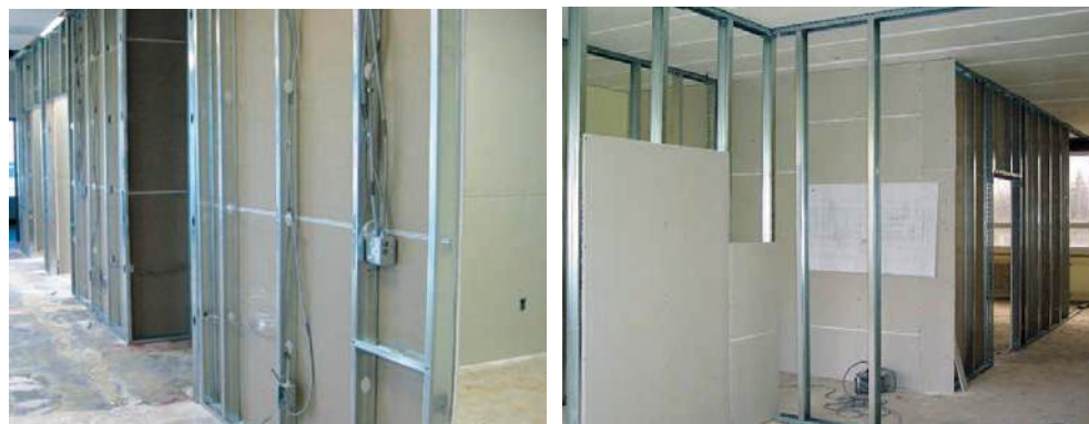
Slika 2-47 Izvedba obloge pregradnog suhomontažnog zida [112]
