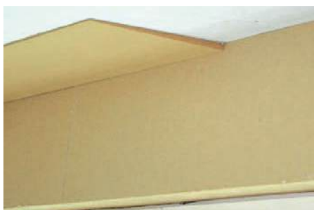
Slika 2-37 Prikaz klina toplinske izolacije susjednih građevnih dijelova [104]
