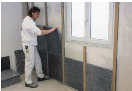
Ugradnja toplinske izolacije
