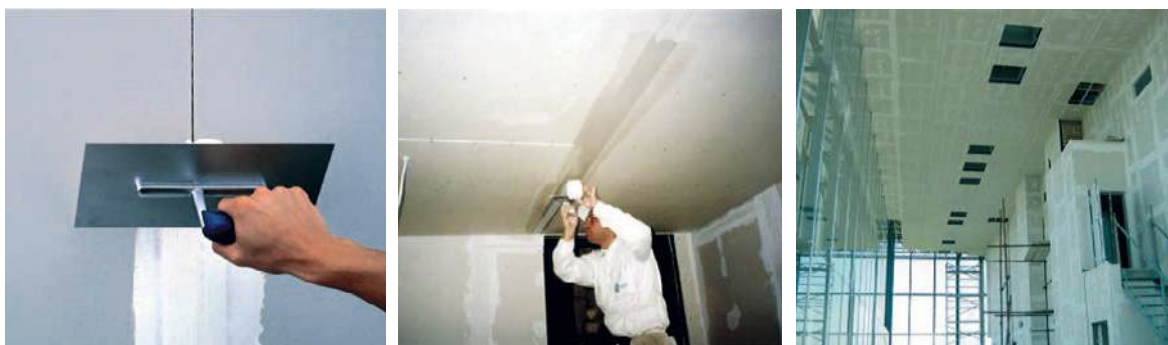
Slika 2-146 Završna obrada površine gipsanih ploča [82]
