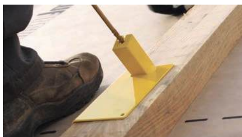
9) Pričvršćivanje kontraletvi na tvrde ploče mineralne vune
