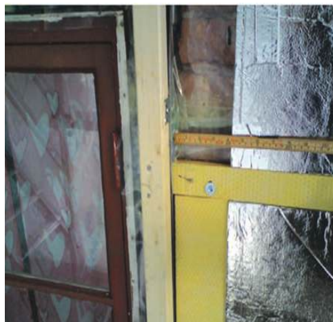
Slika 2-16 Prikaz unutarnje izolacije korištenjem vakumizolacijskih ploča [96]
