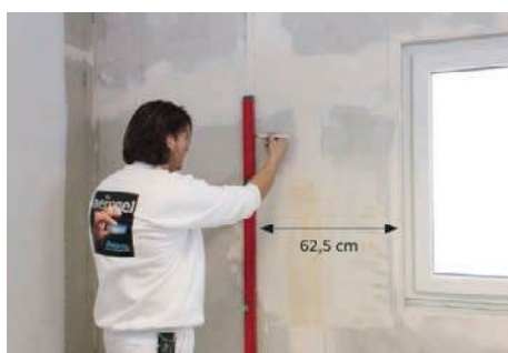
Postavljanje potkonstrukcije, drvene ili metalne
