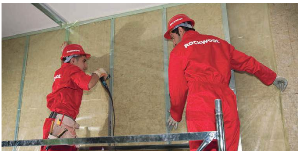
Slika 2-28 Postavljanje parne brane na vanjski zid [1]
