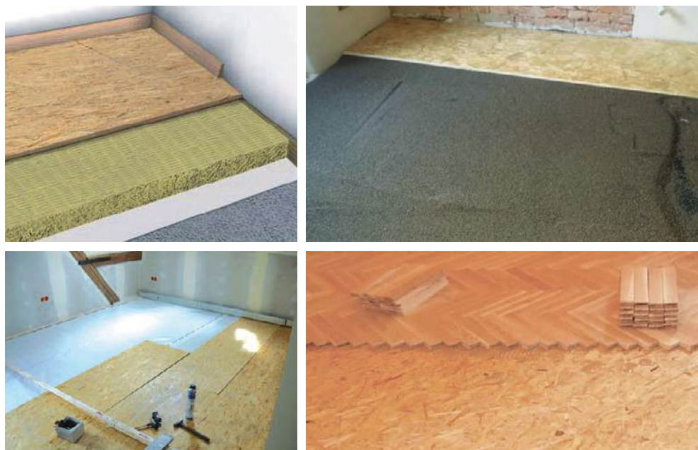
Slika 2-128 Primjeri izvedbe suhog estriha s drvenovlaknastim pločama [1], [168], [169], [170]
