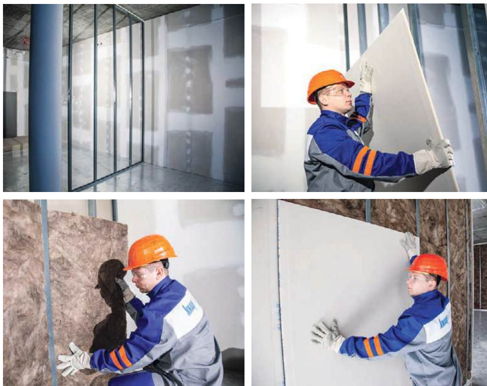
Slika 2-46 Ugradnja mineralne vune [111]
