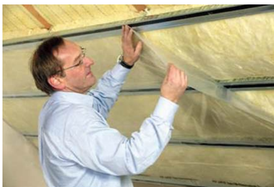
Slika 1-82 Postavljanje parne brane s pristupom iznutra [81]
