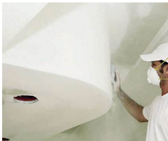
Slika 2-85 Spušteni strop u više razina [129]
